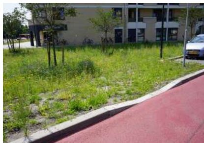
Verlaagde rand langs fietspad voor inlaten regenwater (foto Nanda Sluijsmans)
