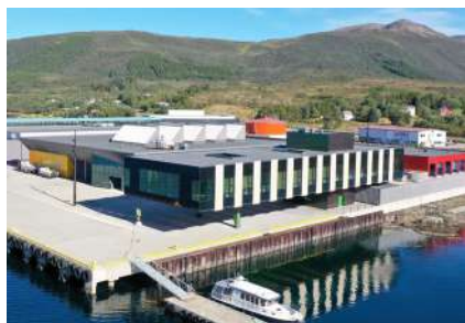
Invriesterminal en kantoor visserijbedrijf. Holmen, Noorwegen (Foto: Øksnes Entreprenør)
