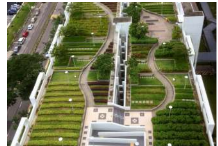
Daktuin op parkeergebouw in Singapore (Foto: Jimmy Tan)
