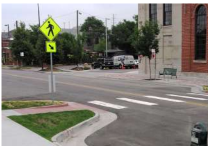
Veilige oversteeplekken met wegversmalling in Canada (Foto: Richard Drdul)
