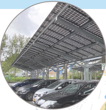
Fig. H.1 Combinatie energie-opwekking met andere functies
