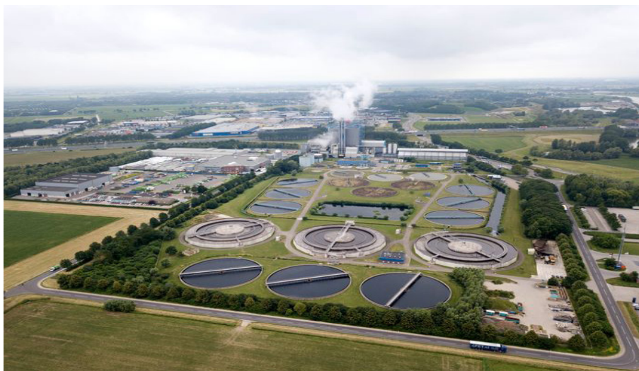
Een biomassacentrale die restwarmte levert aan omliggende huishoudens kan worden gezien als voorbeeld van een huidige kleinschalige energiehub. (Foto: Innofase Duiven)
